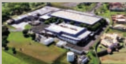
Jaguariúna - SP: Climatização e Arrefecimento
